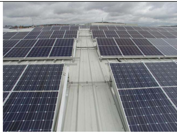
Abbildung 3: Von einem empirischen Modell validiertes großer Solargenerator: Es handelt sich um einen Vergleichstest von zwei verschiedenen Modultypen in Deutschland [4].
